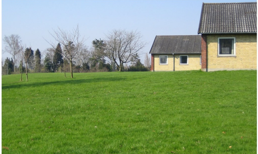
Figur 11: Belægningsbygninger for overordnede (byg. 3 og 4)
