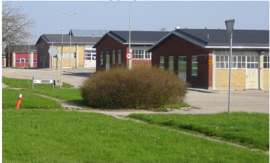
Figur 9: Bygninger i "værkstedsområdet" (bygn. 47, 48, 50 og 54)
