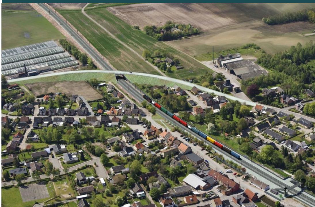
FIGUR 2.7 Syd for den nedlagte overkørsel i Eskilstrup anlægges en ny bro
