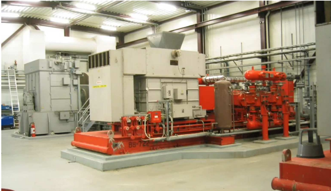
Figur 4-4 – Bygning med kompressorer i Stenlille. 9
