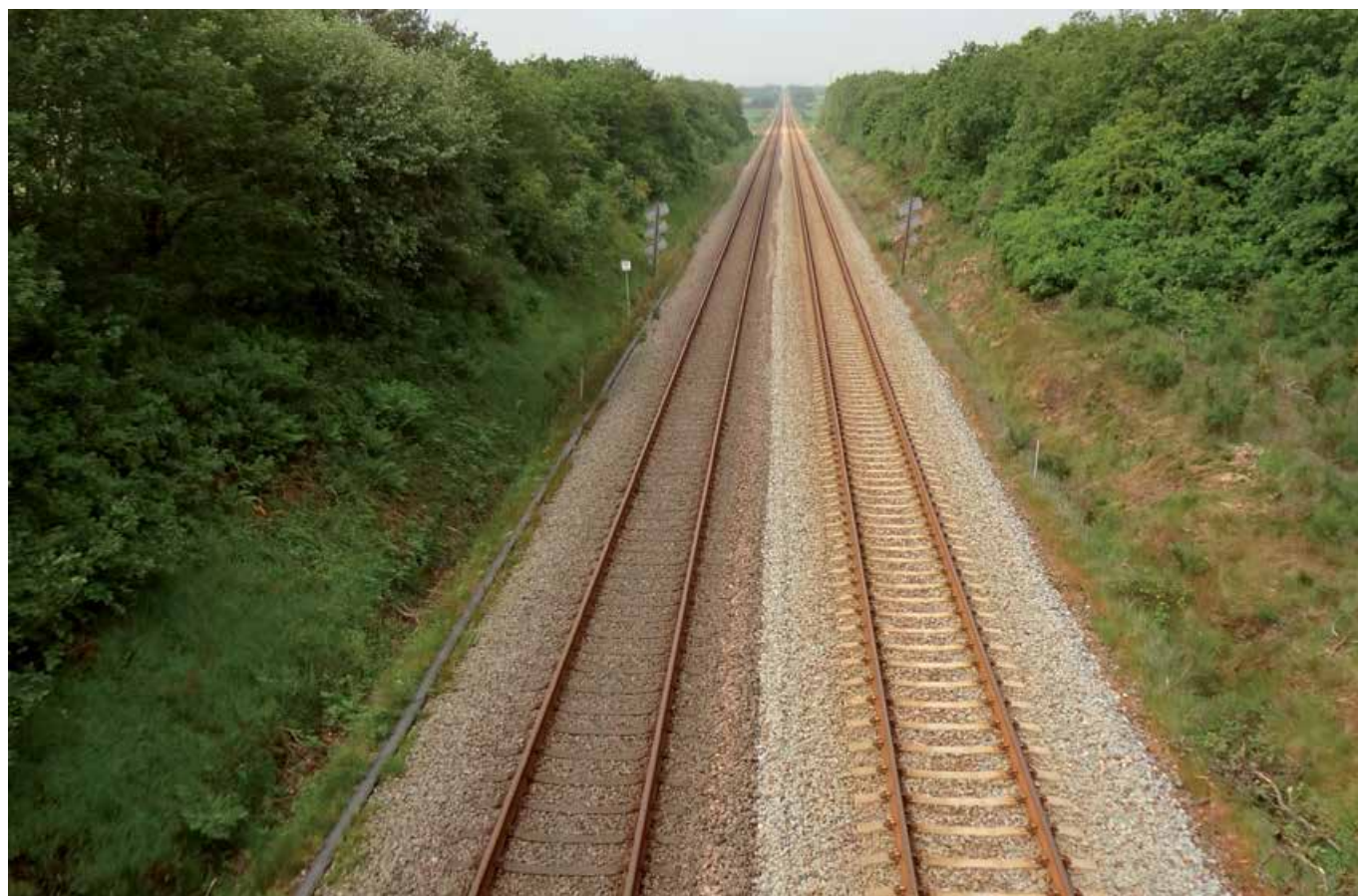
Strækning der skal elektrificeres.
