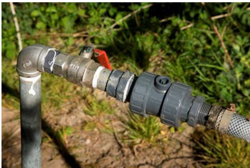
Figur 17. Foto: Jens Tønnesen Fotobureau: Landbrugsmedierne Kontraventil på tapsted er en løsning til at forhindre tilbageløb til ledningsnet
