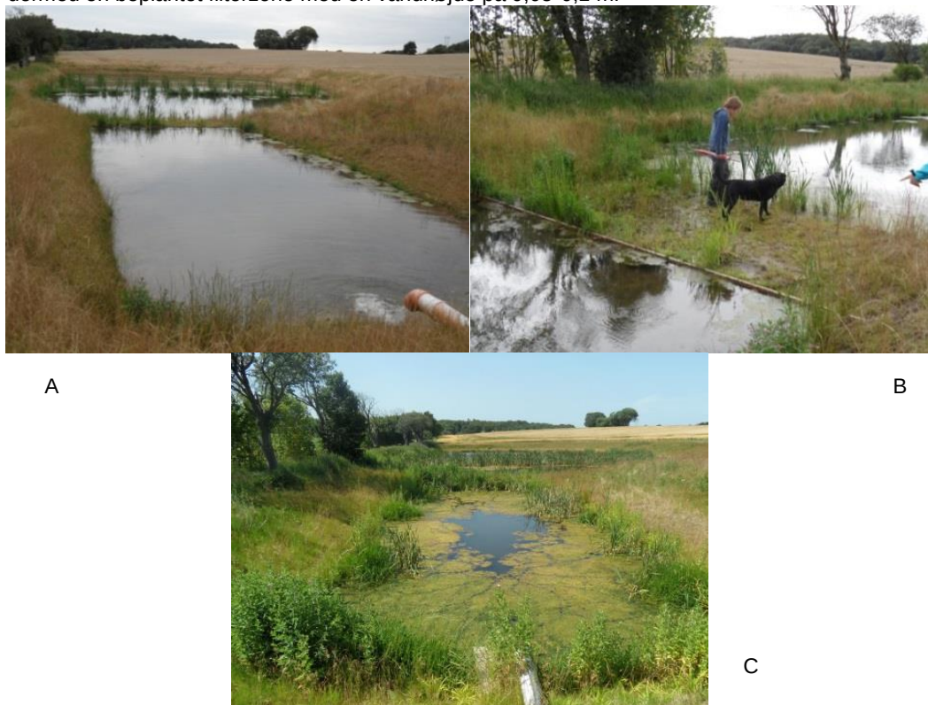
Figur 5. Ny etableret minivådområde (a) foto viser frit drænløb i sedimentationsbassin samt overgangen mellem sedimentationsbassin og vådområde via en beplantet bræmme, (b) beplantet bræmme der danner overgang mellem sedimentationsbassin og vådområde, (c) bræmmen er efter ét år tilgroet med vådbundsvegetation og danner dermed en beplantet filterzone med en vandhøjde på 0,05-0,1 m.
