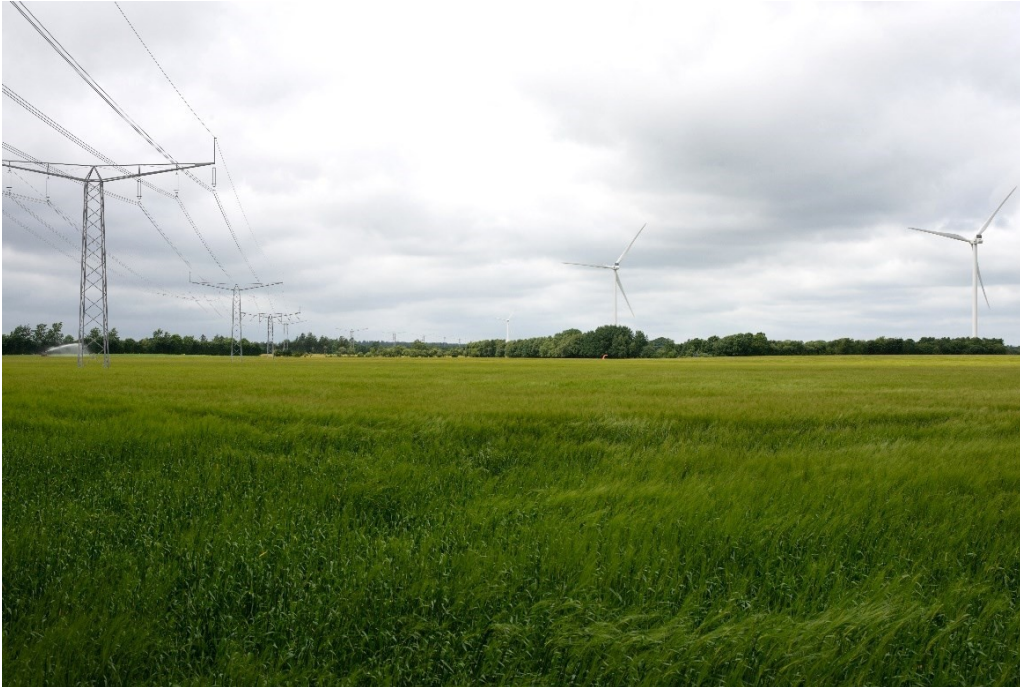
Figur 4. Visualisering af højspændingsforbindelsen ved Ulvemose, der her ses sammen med de eksisterende vindmøller i området.
