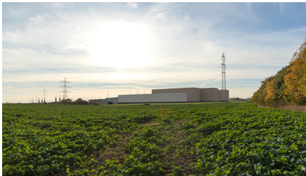
Figur 4.3 Visualisering af volumener af ny bebyggelse; mørkegrå beton på bygningsbase, matte, gule teglmursten over bygningsbase på bygninger over 15 meter og poleret, lysegrå beton over bygningsbase på bygninger under 15 meter.
