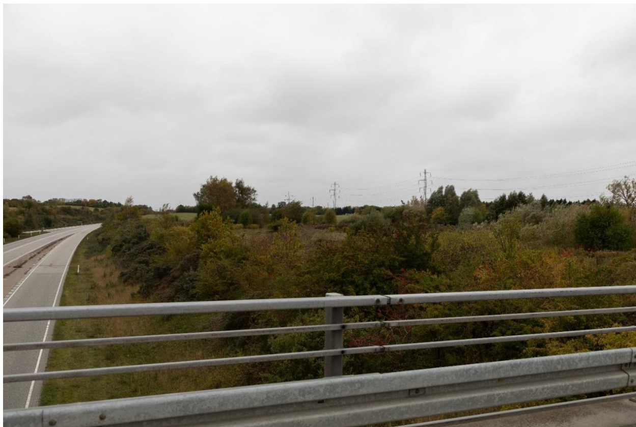
Figur 6-5 Fotopunkt 1 – Eksisterende forhold set fra Roskildevej nordøst for højspændingsstationen.
