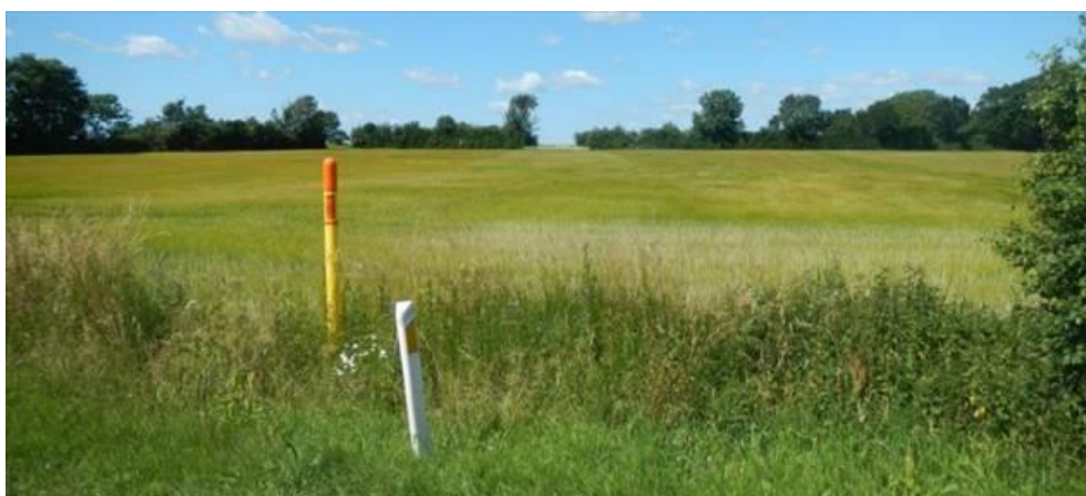
Figur 2-2 Gasrørledning i driftsfasen. Den gul/orange pæl er en markeringspæl, som angiver placeringen af gasrørledningen. Servitutten afstedkommer, at der ikke må være træer oven på gasrørledningen. Dette ses som på billedet som et mellemrum i det levende hegn i baggrunden.
