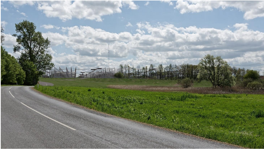
Figur 7.17 Illustration af, hvordan et eksempel på en udvidet Hovegård Højspændingsstation kan se ud lige efter afsluttet anlægsfase og inden etablering af ny randbeplantning. Her vil der være en betydelig teknisk påvirkning af dallandskabet fra både anlæg og terrænregulering. I det viste eksempel er der foretaget omlægning af Lundevej, men denne omlægning indgår ikke som en del af Planen for Hesselø Havvindmøllepark (Illustration: NIRAS A/S).
