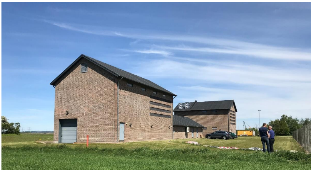
Figur 7.14 Eksempel på en GIS-station placeret i en lukket bygning. Det illustrerer højde, omfang og udtryk på den type stationsanlæg, der forventes etableret som en ny højspændingsstation.
