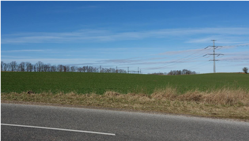
Figur 7.20 I dag er Hovegård Højspændingsstation ikke synlig fra sydøst, idet anlægget er skjult af det bakkede terræn. Kun luftledningerne med tilhørende master indikerer anlæggets tilstedeværelse (Foto: NIRAS A/S).
