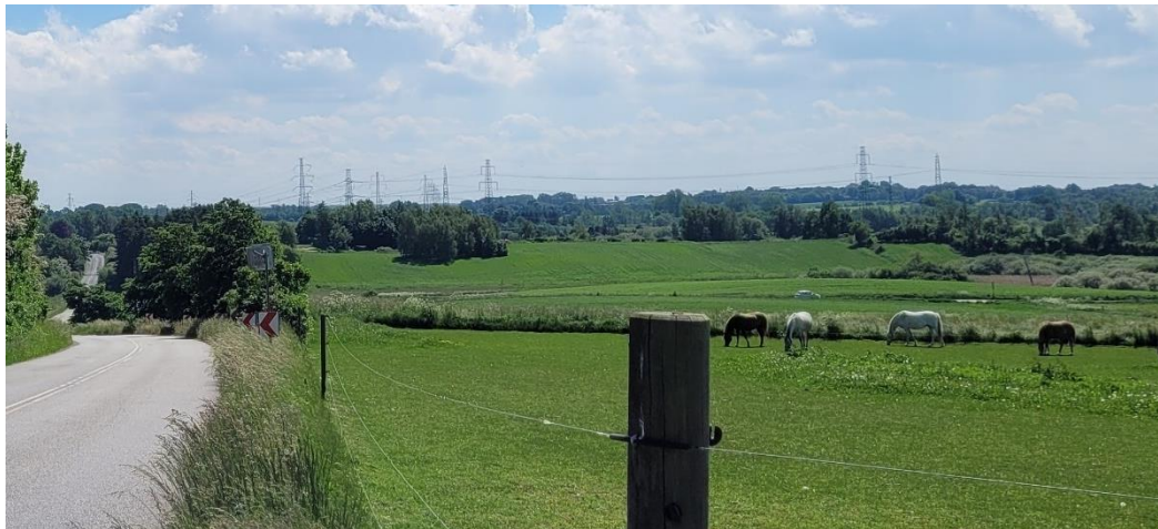
Figur 7.8 Udsigt på tværs af dallandskabet fra nord i retning af Hovegård Højspændingsstation. Det er tydeligt, at landskabet er præget af højspændingsmaster og -ledninger, der tilfører landskabet en betydelig teknisk prægning. (Foto: NIRAS A/S)
