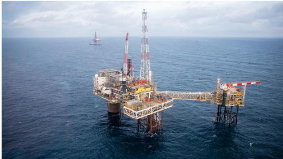
Abbildung 3-4 Süd Arne und die Bohrkopfplattform Ost, Wellhead Plattform Nord in Hintergrund.
