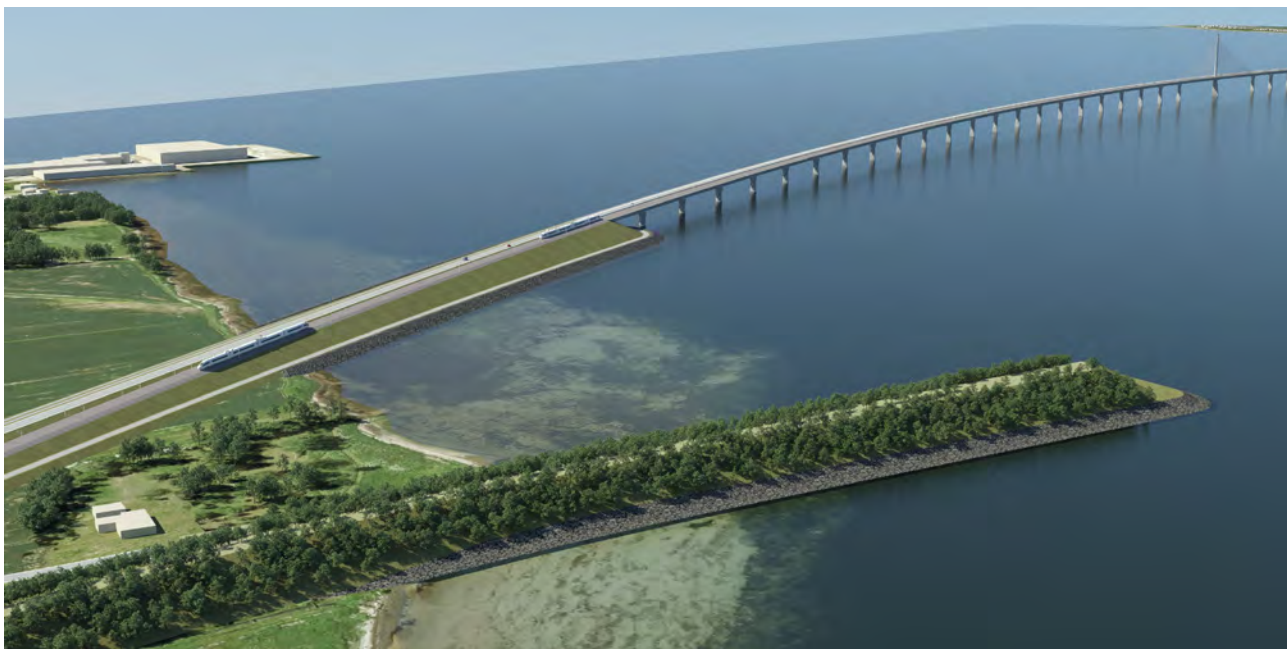
Figur 4.10 Broens landfæste på Falster set fra luften
