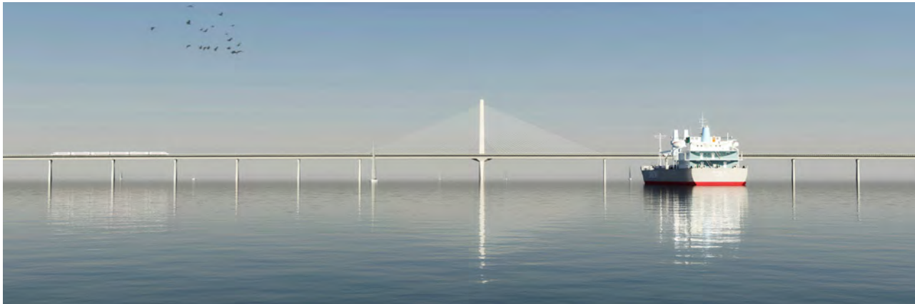
Figur 1.1 Skråstagsbro med sidefag og gennemsejlingsfag
