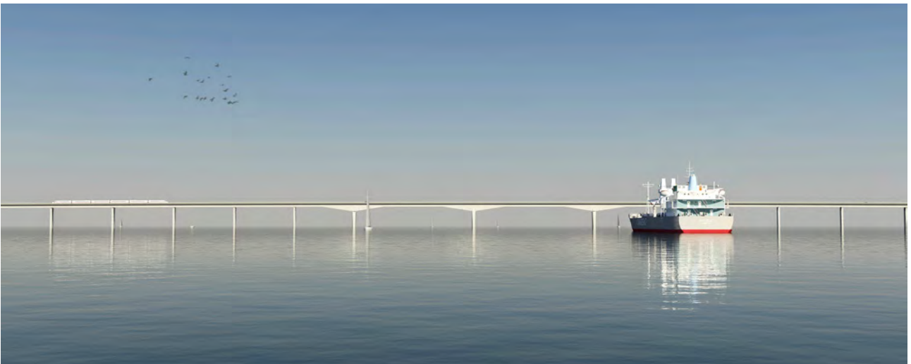
Figur 4.7 Bjælkebro med sidefag og gennemsejlingsfag
