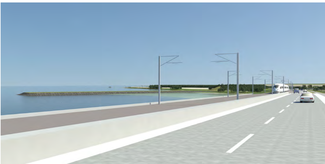
Figur 11.1 Dæmningerne på Falster med projektforslaget øverst og tilvalget nederst, hvor den eksisterende dæmning henholdsvis bevarer eller fjernes til ca. 4 m over havoverfladen.
