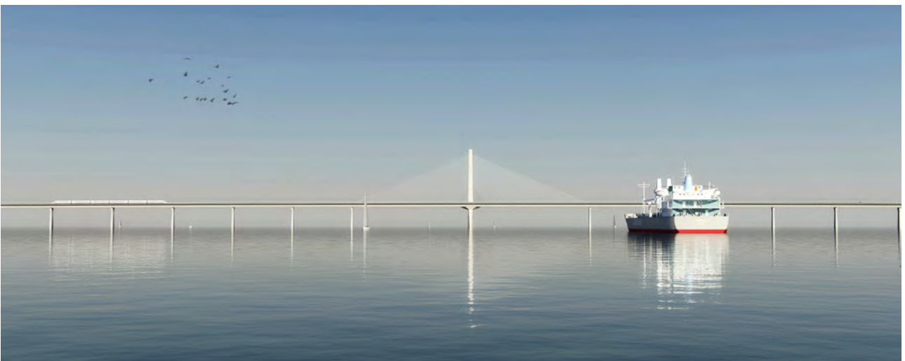
Figur 4.8 Skråstagsbro med sidefag og gennemsejlingsfag
