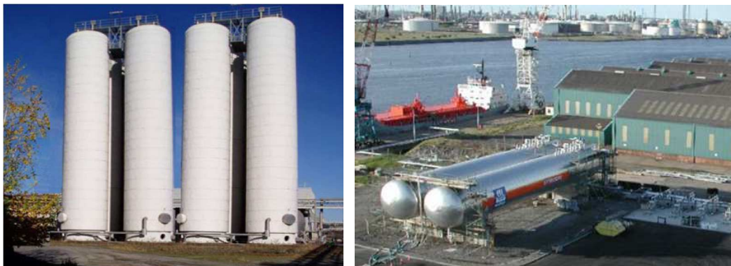
Figur 4-6 – Eksempler for mindre lagertanke til opbevaring af CO 2 . 13
