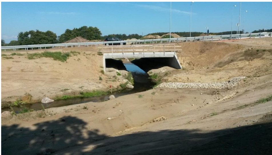
Figur 8. Den nye faunapassage under Vejdirektoratets nyetablerede vej ved Gl. Sorøvej.
