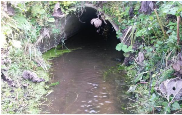
Figur 2 Eksisterende vandløbsunderføring for Valmosegrøften
