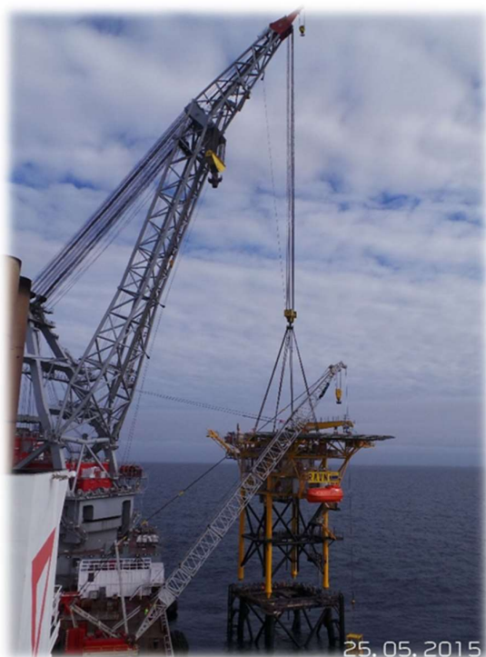
Abbildung 3-8 Anheben der Aufbauten (Beispielfoto für das Aufrichten)
