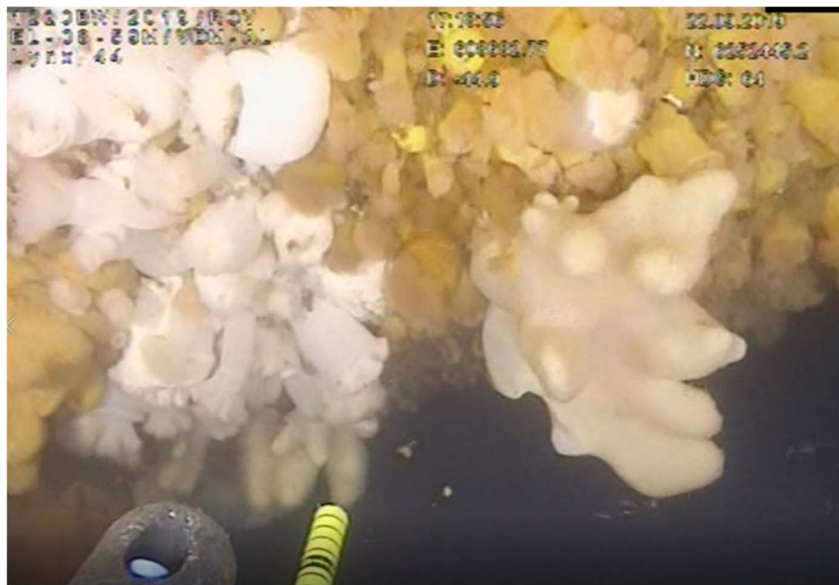
Figur 6-15 Eksempel på marin vækst (begroninger) på jacket.
