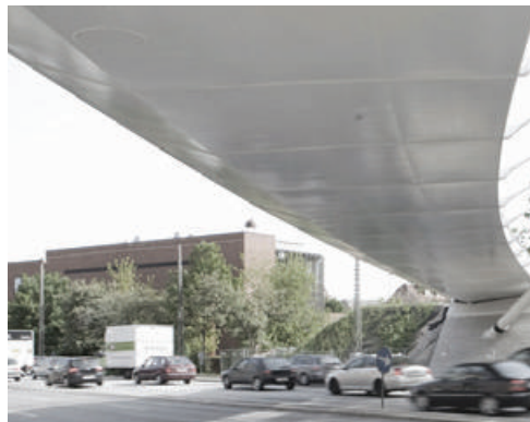
Underside i glat stål
