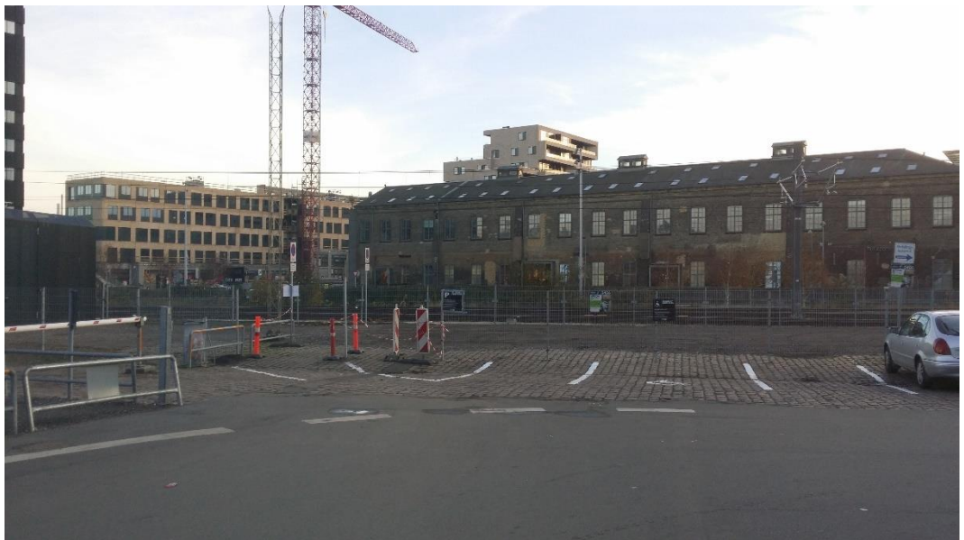
Figur 9-5 Centralværkstedet og nyere byggeri ved Frederiks Plads i baggrunden set fra nord over det åbne baneterræn øst for banegården.
