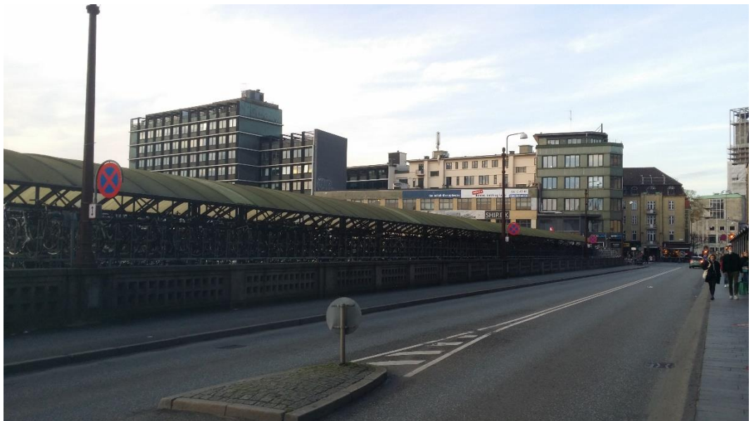
Figur 9-3 M.P. Bruuns Bro og overdækket stibro med cykelparkering og adgang til perroner.
