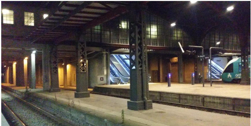
Figur 9-2 Perronhallen ved spor 2 og 3 med rulletrapper til Vandrehallen.
