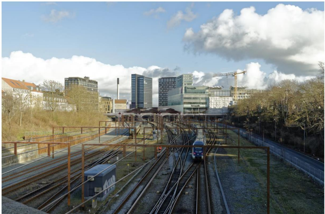
Figur 3-9 Elektrificering med ophæng på rammer.
