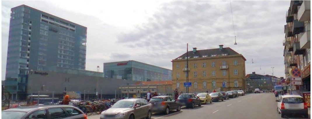
Figur 9-4 Posthuset og Bruuns Galleri østlige facade
