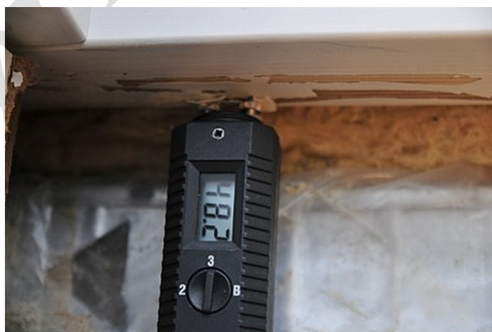
Figur 5: Fugtmåling i vindueskarm af træ.
