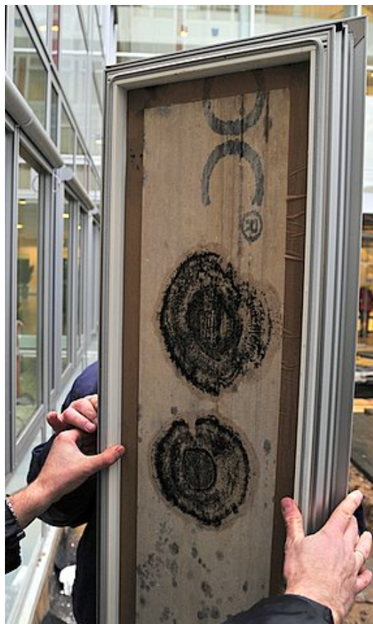
Figur 6: Fund af skimmelsvamp ved undersøgelse af bygning.
