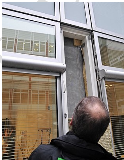
Figur 12: Indeklimarådgiver i gang med at undersøge en bygning.
