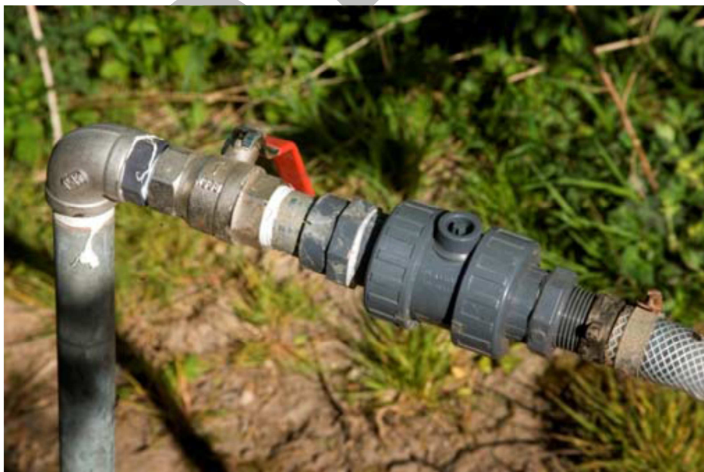
KONTRAVENTIL PÅ TAPSTED FORHINDRER TILBAGELØB TIL LEDNINGSNET FOTO: JENS TØNNESEN, LANDBRUGSMEDIERNE
