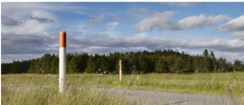
Figur 14 Eksempel på markeringspæl ved en gasledning. Der kan være flere forskellige udformninger og farver på markeringspæle.
