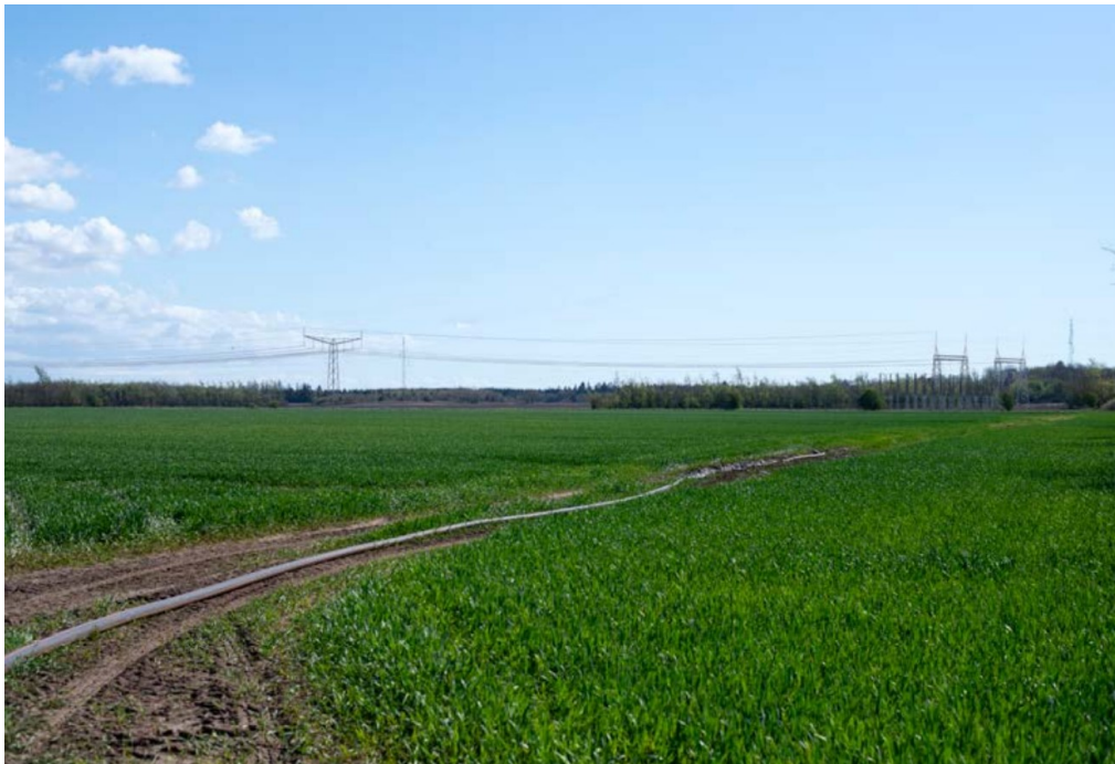
Figur 10. Visualisering af kabelovergangen og master syd for Brede Å på en strækning, hvor højspændingsforbindelsen følger samme trace som 150 kV luftledninger, der fjernes.
